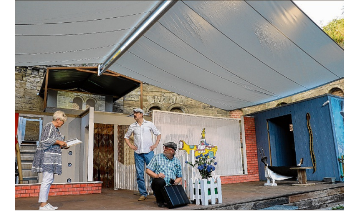
Das neue Stoffdach hält künftig die Bühne im Fort A trocken.
